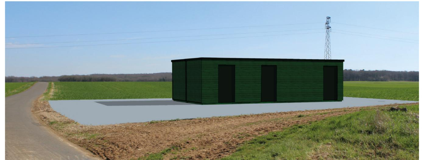
Figure 35 : Simulation d'intégration du poste de livraison avec couleur béton teinté vert (non retenu)
